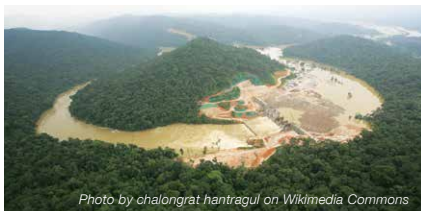
南通2號水力大壩
